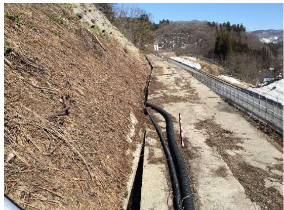
写真 2.2.1 近接アンカーが過緊張に至っていた箇所の付帯構造物の変状
