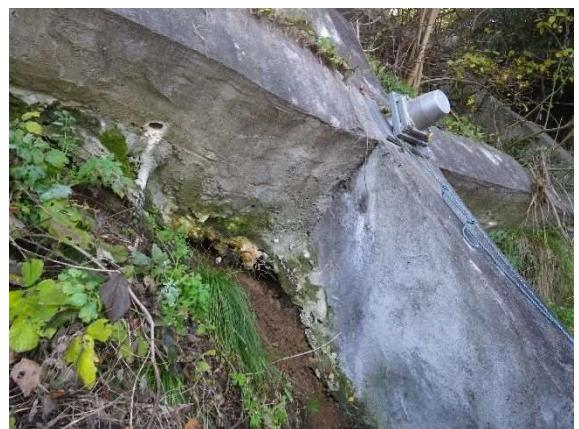
写真 2.2.2 付帯構造物(受圧構造物)の変状
