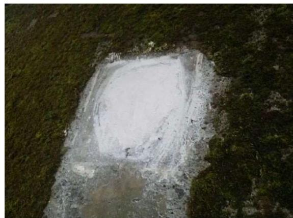
写真 4.4.10 アンカー孔の埋戻し状況
