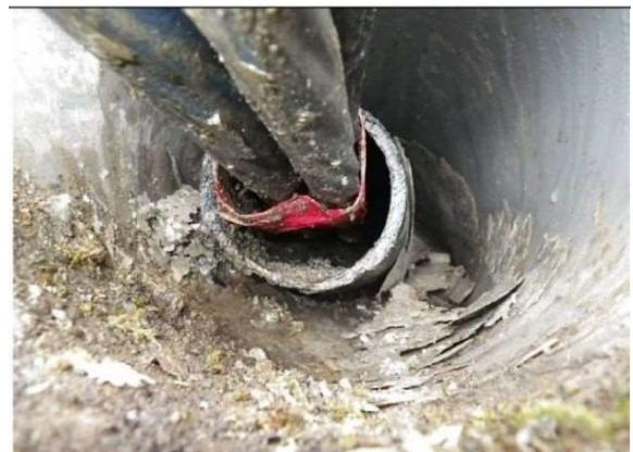
写真 4.4.3 地下水が溜まり、泥付着する
