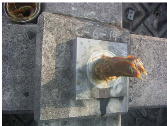
頭部処理状況
