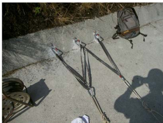
参・図 7.1 アンカーボルトによる設置状況
