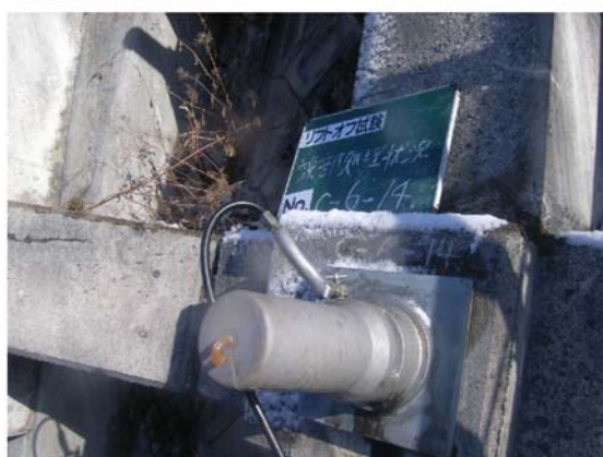
頭部処理状況
