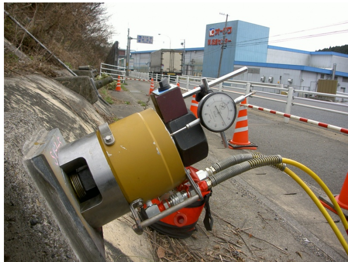
写真 2.1.1.1 SAAM ジャッキ設置状況 (N タイプ)
