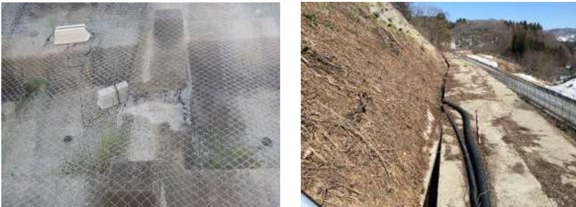
写真 2.2.1 近接アンカーが過緊張に至っていた箇所の付帯構造物の変状
