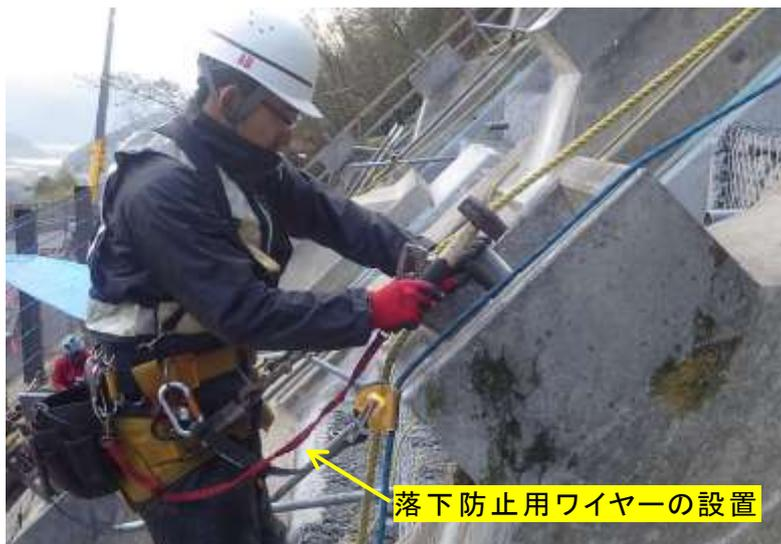
写真 3.5.2 点検用具の落下防止対策(例)
