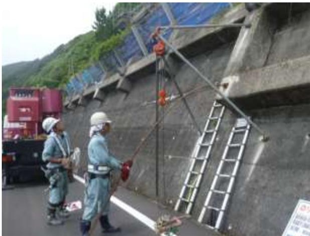
写真 4.4.7 引抜き作業状況
